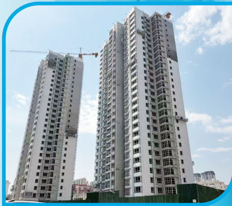
建设中的大白峪社区回迁楼。
