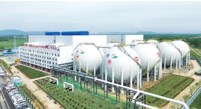
■300MW/1800MWh先进压缩空气储能系统。 通讯员供图
