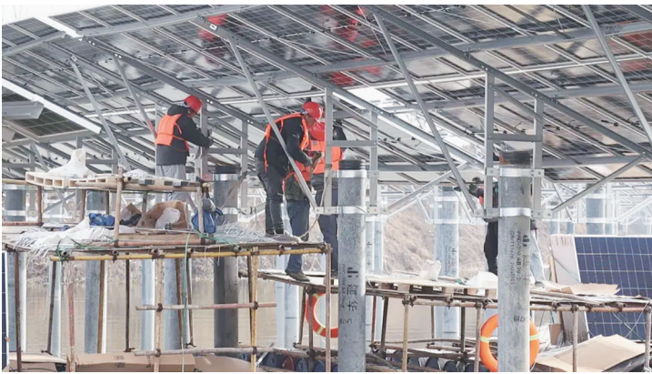
项目建设现场。
