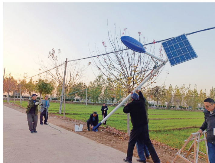
工人在安装路灯。 通讯员供图
