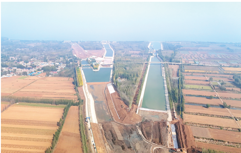
■柳长河段“三改二”工程建设现场。 记者 李腾腾 摄
