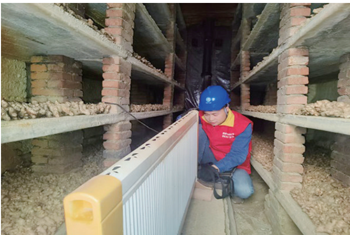
■工作人员为生姜储库接电。 通讯员供图
