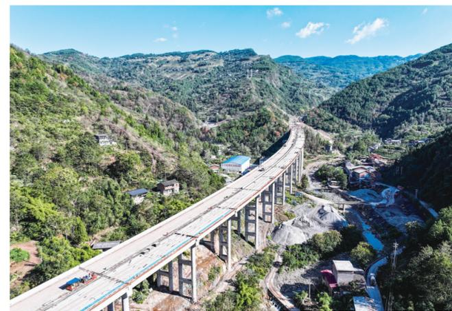
这是10月18日拍摄的建设中的万开达高速公路漆树梁大桥(无人机照片)。当日，随着架桥机将最后一块长40米、重140吨的T梁精准平稳地架设在桥墩上，由中铁二十五局承建的万开达高速公路漆树梁大桥顺利贯通。此次贯通的漆树梁大桥位于重庆市开州区南河镇，采用左右分幅设计，左幅全长851米，右幅全长845.6米，是万开达高速公路的重要节点工程。
