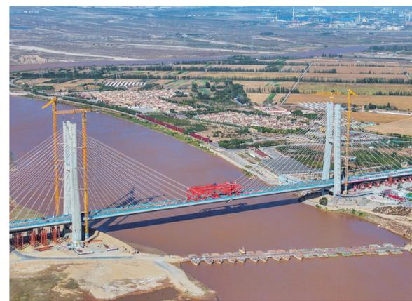
10月9日，包银高铁乌海黄河特大桥合龙贯通(无人机照片)。当日，包银高铁乌海黄河特大桥顺利合龙贯通，为线路早日建成通车迈出坚实一步。包银高铁是我国“八纵八横”高速铁路网京兰通道的重要组成部分，设计时速250公里，是西北地区连接东北、华北地区的交通大动脉和经济大通道。
