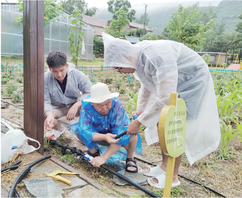
■团队成员安装调试自动灌溉系统。
