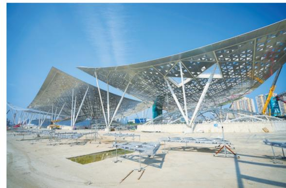
8月30日，施工人员在北京城市副中心站枢纽工程现场施工。当日，作为京津冀协同发展交通标志性工程的北京城市副中心站综合交通枢纽主体结构封顶，首片“京帆”屋盖完成安装，工程全面转入机电设备安装和装修施工阶段。
