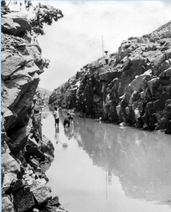
泰安人民开山劈岭修建胜利渠。
