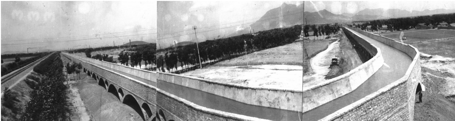
胜利渠通水试验。
