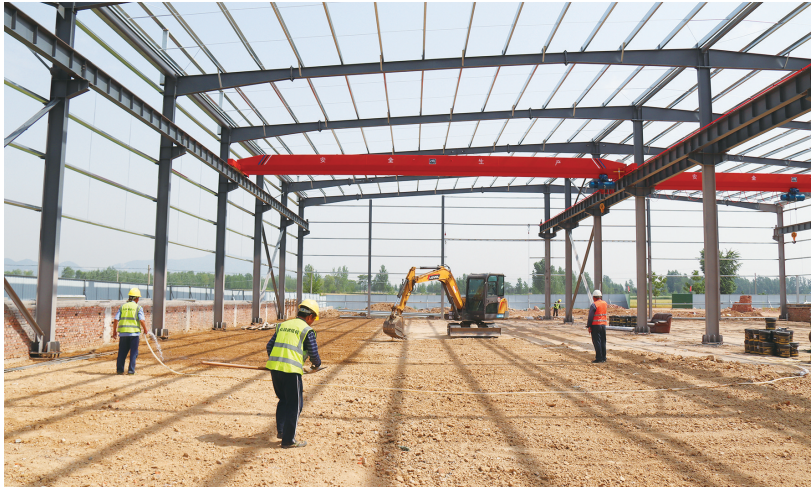
■海瑞拓通用通风设备生产线项目建设现场。 通讯员供图
