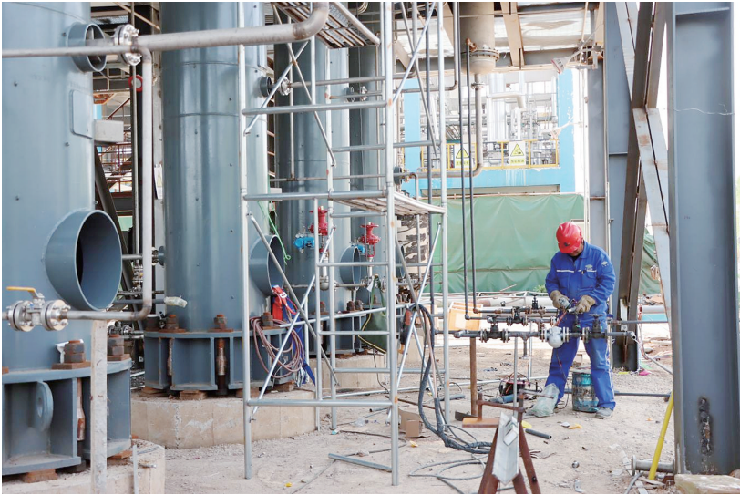
■聚发生物烯丙基胺精制提纯项目改造现场。
