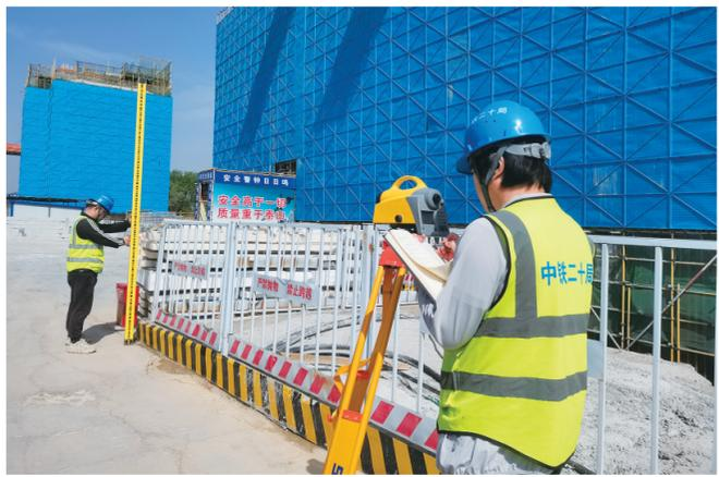
■施工现场,测量工程师进行房建主体监测。 记者 马欣妮 摄
