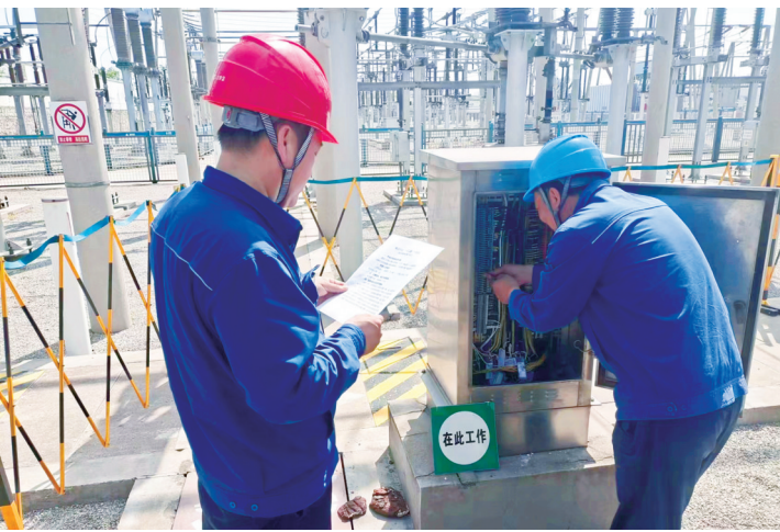
■工作人员对照明白纸进行检查。
