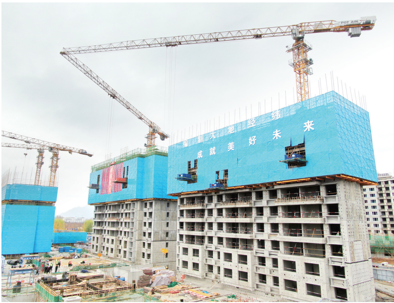
■邱家店镇崔家庄村旧村改造项目施工现场。 记者 蒋亮亮 摄
