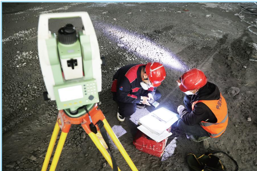
地下厂房岩壁爆破样架定位复测。
