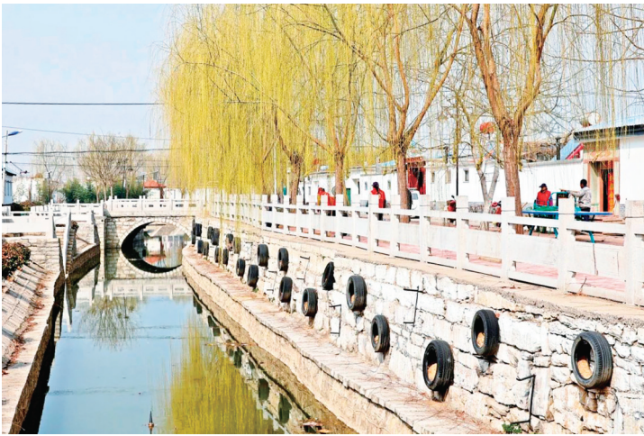
■升级改造后的河道岸边。
