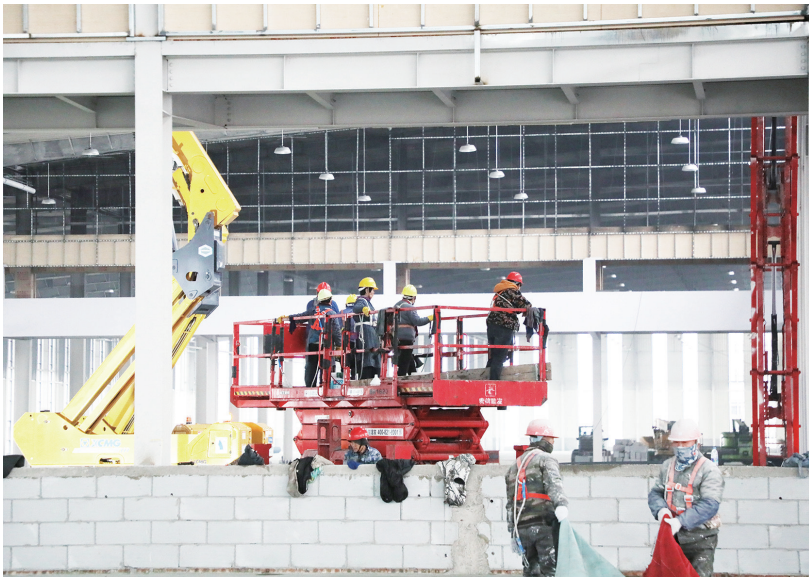
■大窑饮品生产项目施工现场。
