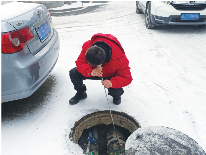
■巡查人员利用听筒排查漏点。
