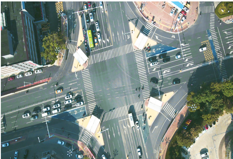
■市城市管理局对东岳大街与迎胜路交叉口进行了改造提升。这是改造提升后的路口全景。
