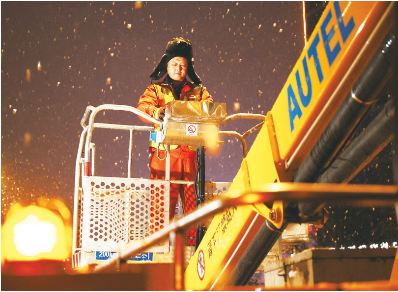
■路灯所工作人员冒雪检修路灯设施。 最泰安全媒体记者 隋翔 摄
