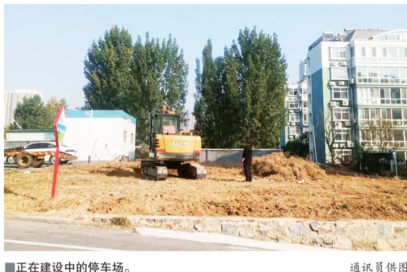
正在建设中的停车场。
