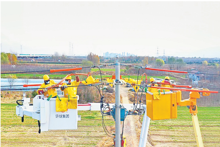
■工作人员带电更换开关。 通讯员供图
