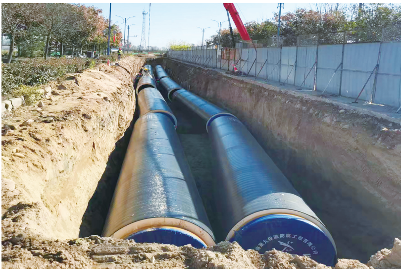
■莱热入泰长输供热管网工程建设正全力推进。 通讯员供图
