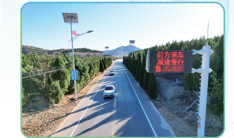
▲弯道雷达预警系统提醒过往车辆提前减速。 ▼仪汶路棋石岭路段。
