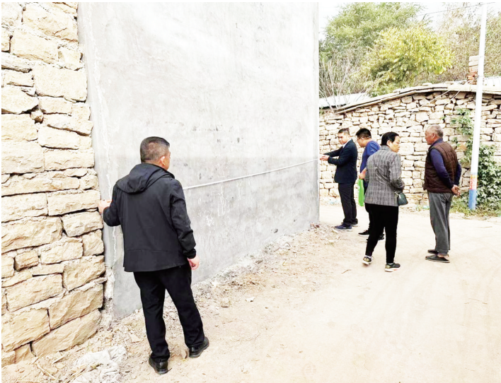
■工作人员对危房改造项目进行验收。
