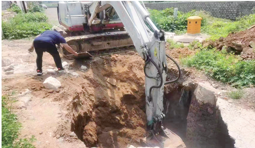
■对塌陷进行修缮填埋。
