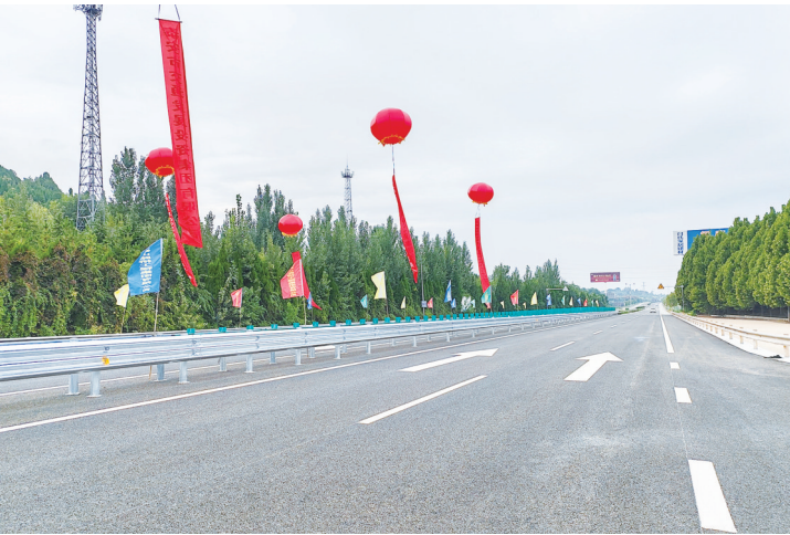
■中修后的泰肥一级公路。
