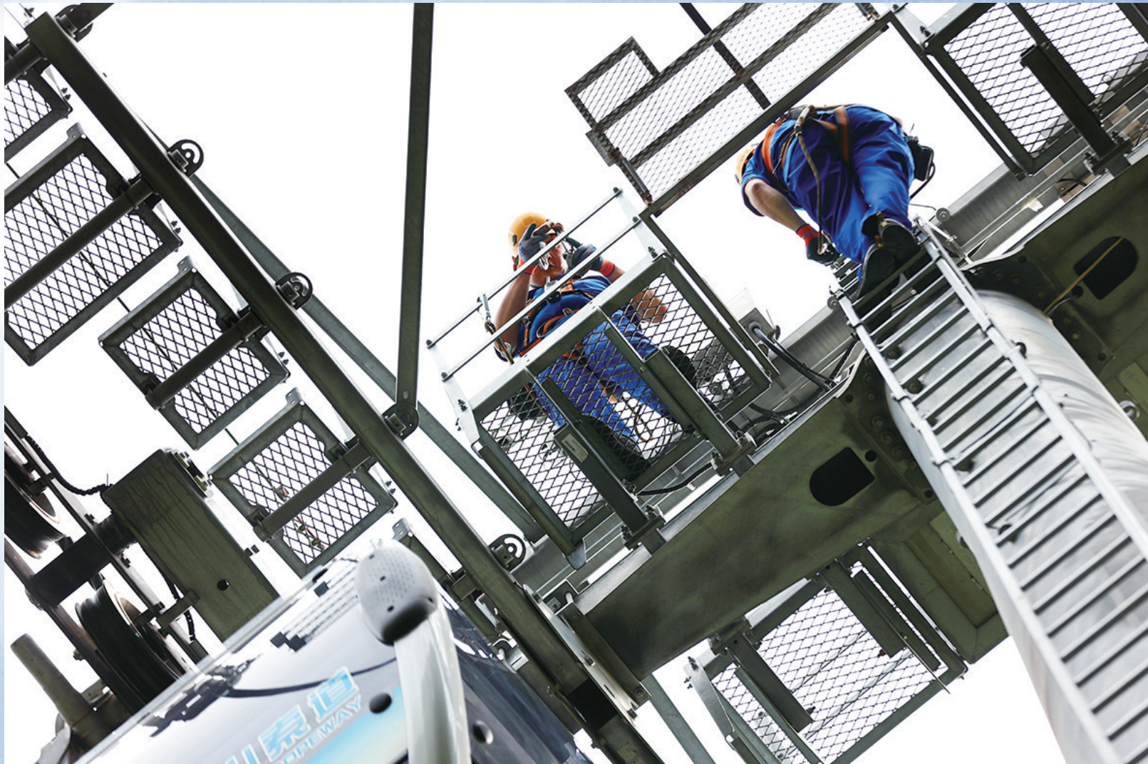
爬上索道支架高空作业。
