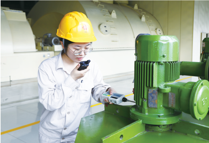
■工作人员测量排烟风机振动数值。 通讯员供图
