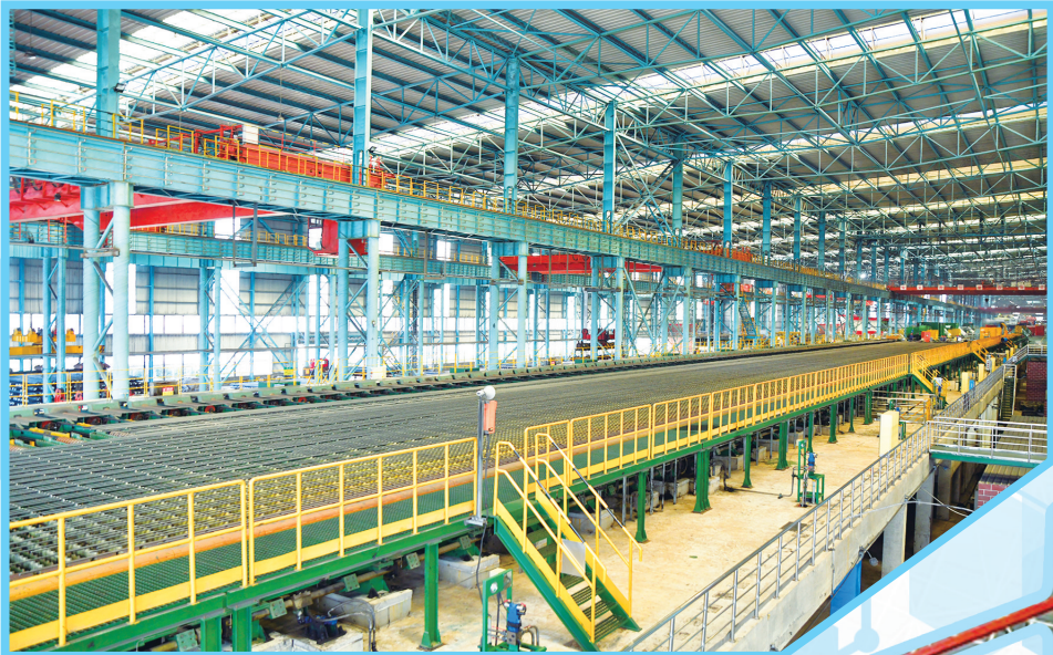
石横特钢棒材型钢生产建设项目(肥城)。
