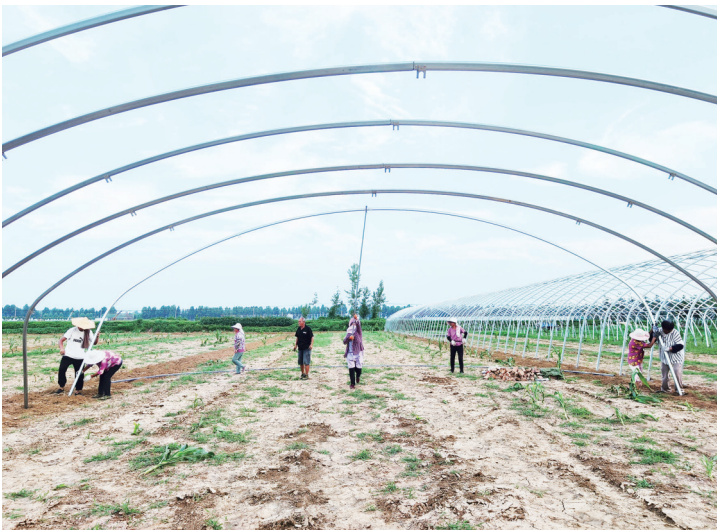
■钢架大棚建设现场。
