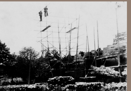
●照片8 1984年修复正阳门现场。
