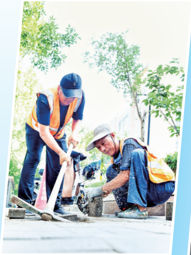
路政维护人员维护人行道。
