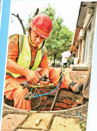
路灯巡查维修人员检修供电线路。
