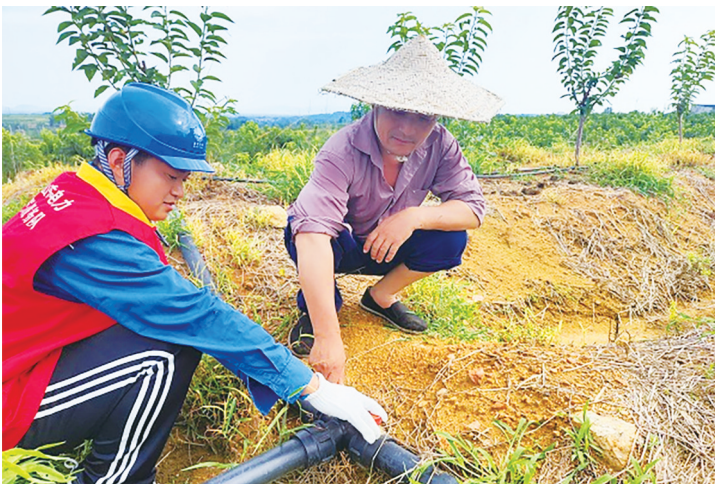
■工作人员检查灌溉用电设备。
