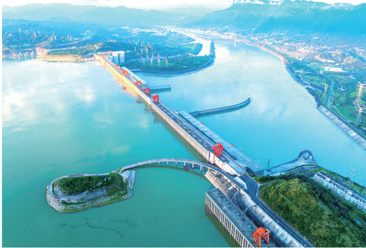
这是2023年7月9日在湖北宜昌市拍摄的三峡水利枢纽工程(无人机照片)。
