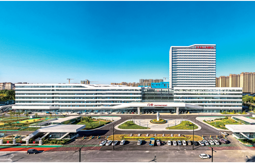
齐河县现代化高端医疗综合体。
