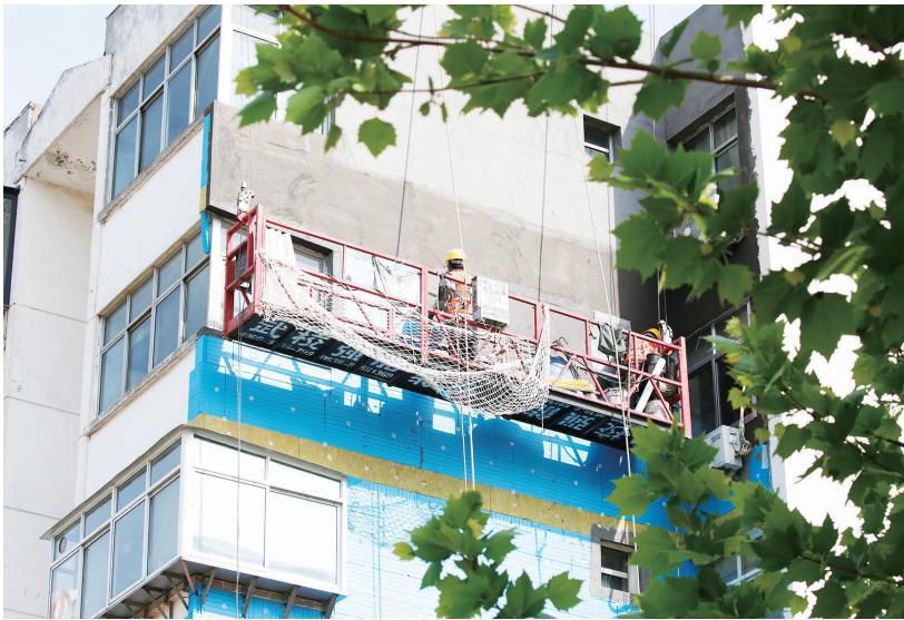
■泰山区老旧小区改造施工现场。 最泰安全媒体记者 陈阳 摄
