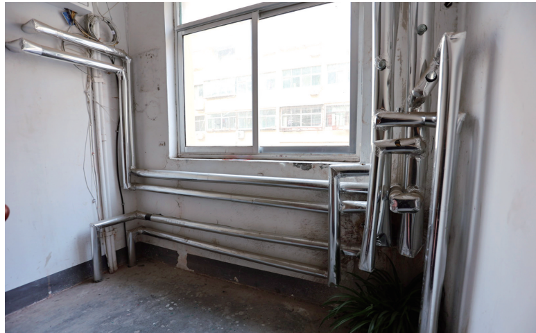
■楼道内新安装的供暖管道。最泰安全媒体记者 隋翔 摄
