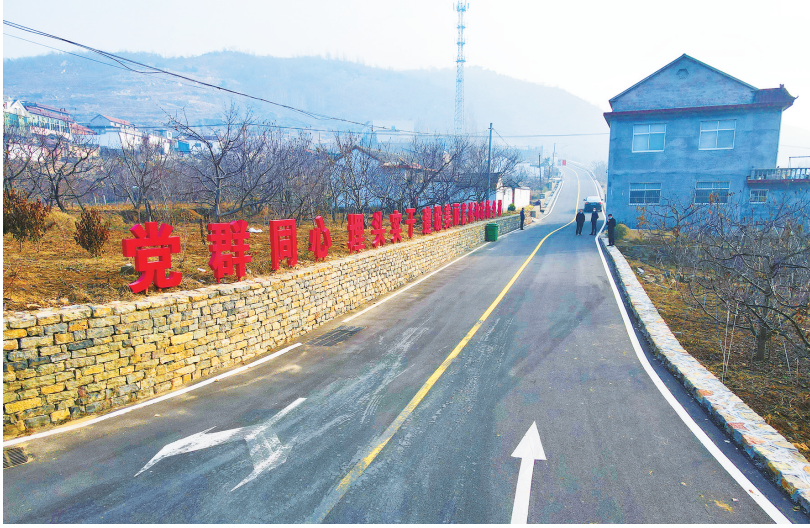
■平坦的沥青路方便了洪山村农产品外运。 最泰安全媒体记者 隋翔 摄
