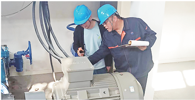
■工作人员对供水设备进行维护保养。
