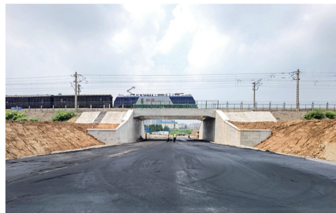
工程施工现场。最泰安全媒体记者 亓浩波 摄
