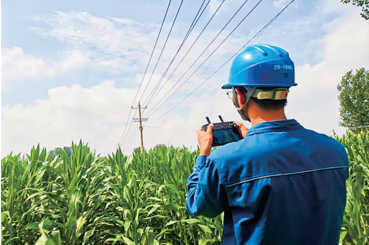
■工作人员使用无人机巡检线路。 通讯员供图
