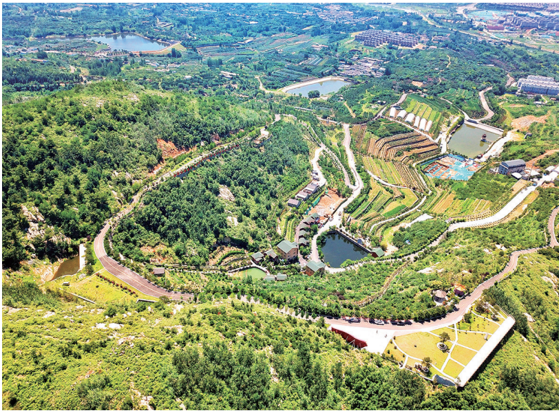
■从山顶俯瞰安家庄村水土保持科技示范园。 最泰安全媒体记者 陈阳 摄
