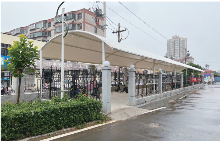
■新修建的充电车棚。 通讯员供图
