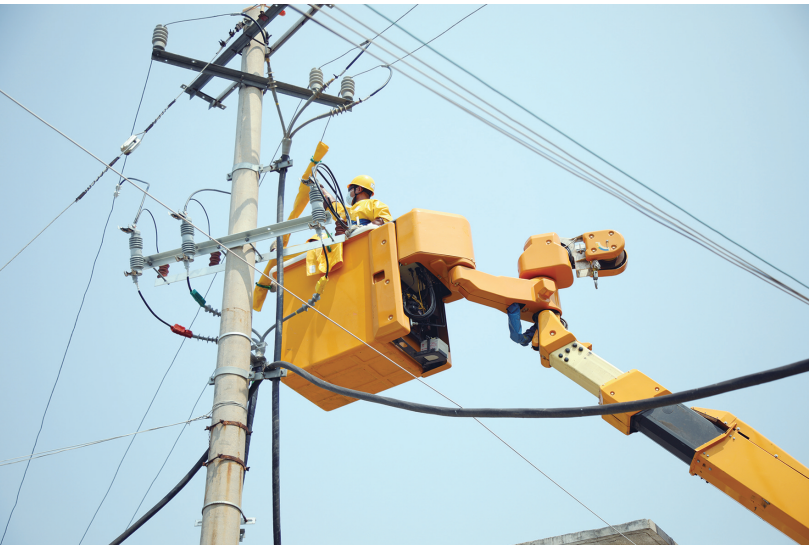
■国网泰安供电公司工作人员进行高空作业。 通讯员供图
