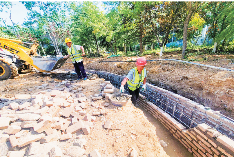
■澳泰山庄游园避雨廊建设现场。
