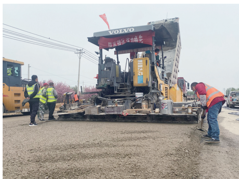
环山路东延二期改造施工现场。 最泰安全媒体记者 秦浩 摄
