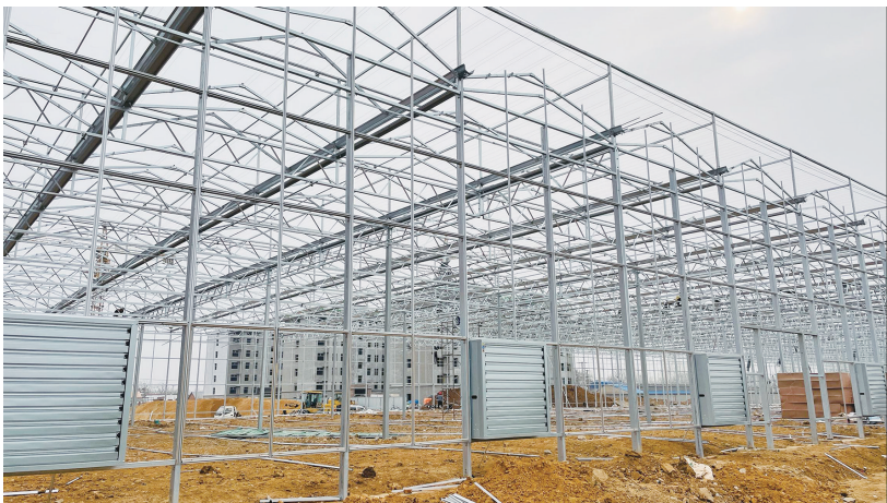
■项目建设现场。
