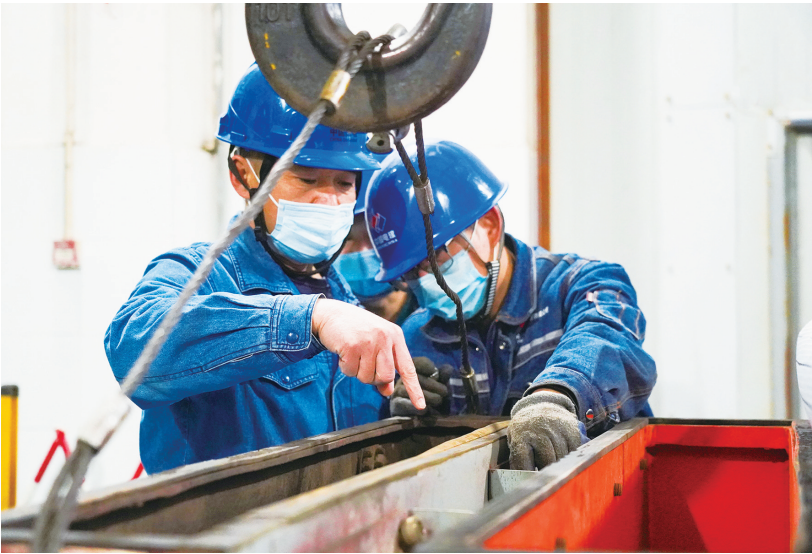
■工作人员对一号机组开展检修。
